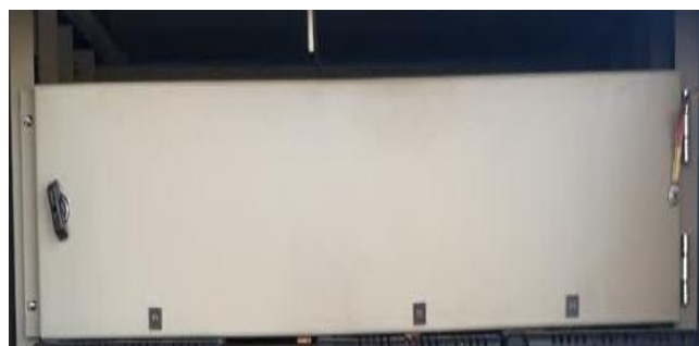
شکل (۱) نحوه ساخت روبند تابلو
