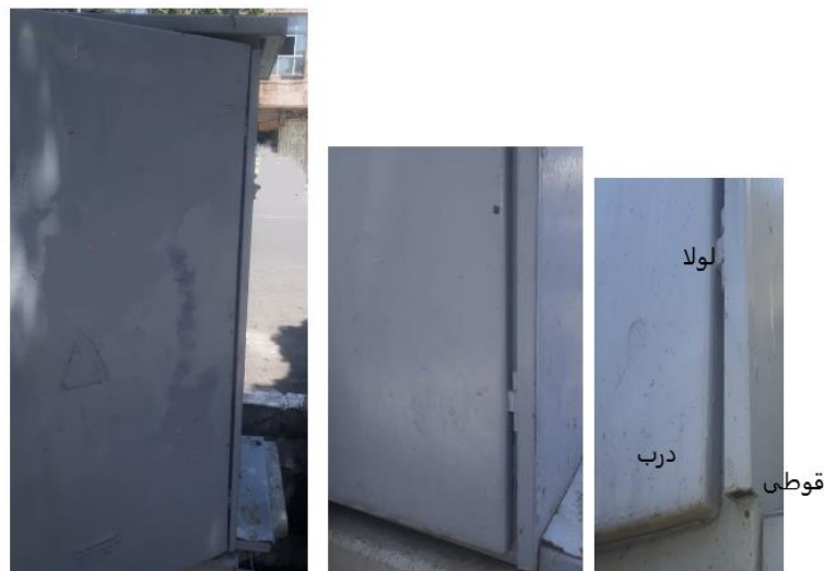
شکل (۶) استفاده از قوطی جهت استحکام لولا
